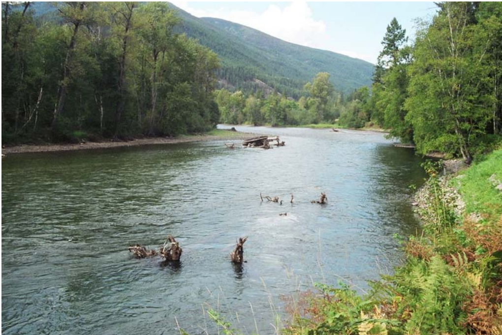
Colocación de estructuras de troncos en el cauce para la mejora del hábitat piscícola.
