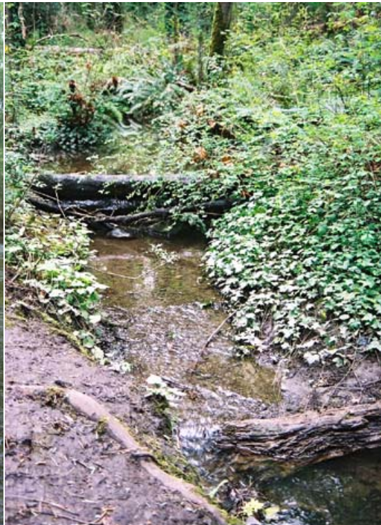
Colocación de troncos en arroyo para retención de sedimentos y formación de pozas.
